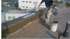
パラペット樹脂防水
