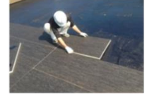
断熱パネル張り
